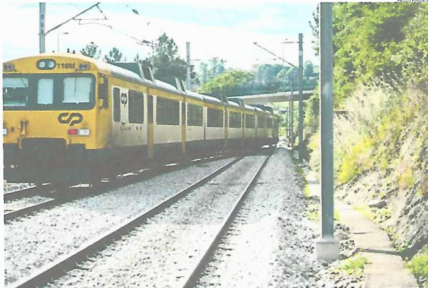
Funcionários vigiam linha férrea, fazem obras de manutenção e fiscalizam empreitadas
