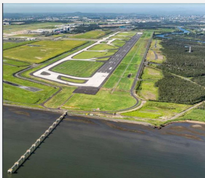
Nova pista 3.300m construída sobre aterro de areia dragada
