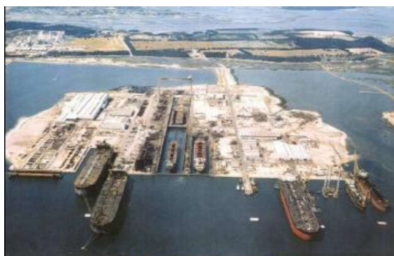
Vista geral do estaleiro em 1975
