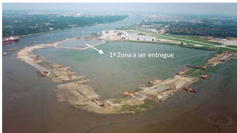
Avanço dos trabalhos quatro meses após o arranque
