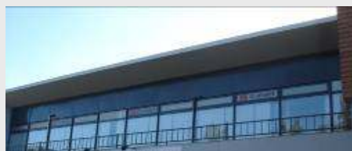
Forte da Casa (Lisboa) 6.600 m 2
